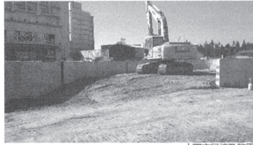
土石方回填及整平
