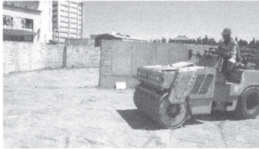
壓路機夯壓處理
