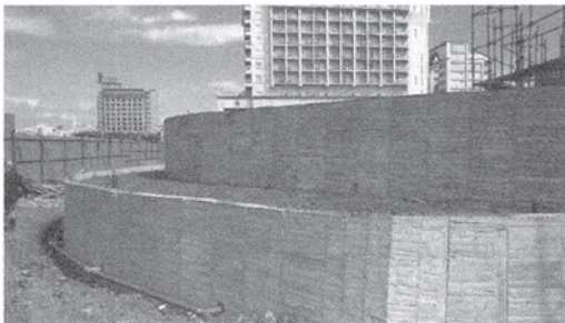
擋牆混凝土結構
