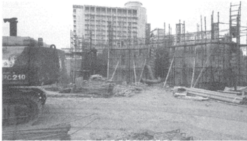
廁所牆面模板組立
