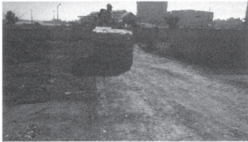
壓路機夯壓處理
