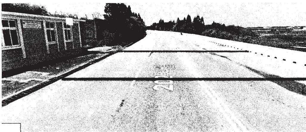
成功抽水站前設置 2 條 16 米長穿越線道直接排至大海箱涵排水及觀景平台計 200 萬元
