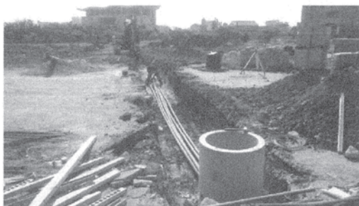
電信管線配管及埋設
