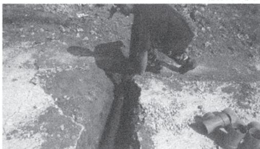
排水管配管及埋設
